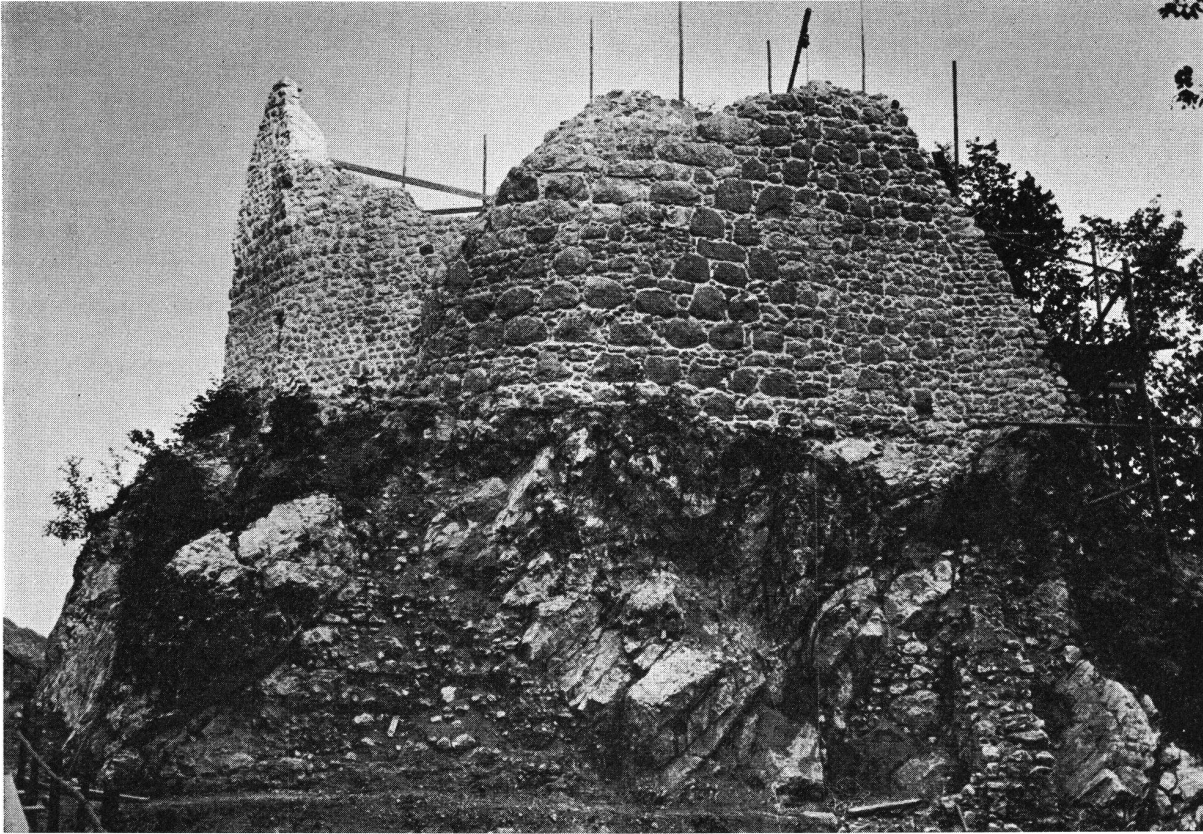
Löwenburg (BE). Beispiel einer Burgruine, deren Restaurierung nur aufgrund einer umfassenden Ausgrabung und Bauuntersuchung möglich geworden ist.
