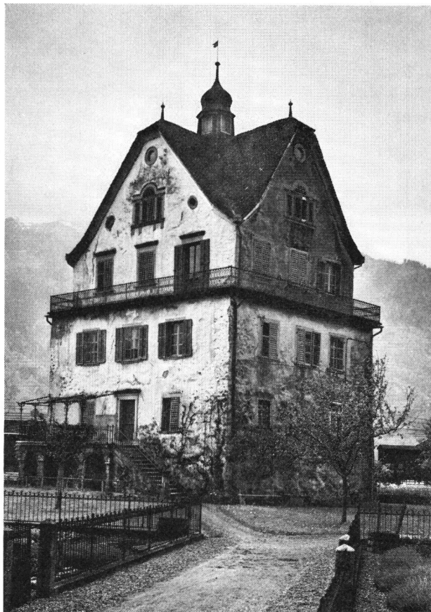
Flüelen UR, Turm Rudenz. Wird vom SBV am 7. September besichtigt.
