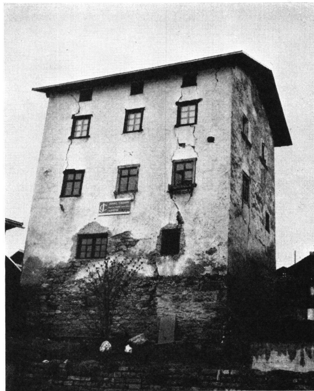
Turm Cas'aulta, Lumbrein. Ansicht von Süden vor der Restaurierung.
