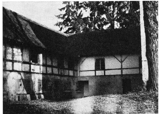
Hofansicht des Ökonomiegebäudes. Unten links Wohnung mit Schmiede, darüber Gesindekammern mit hofseitigem Korridor, rechts Zwischenbau mit Stall und Laube.
