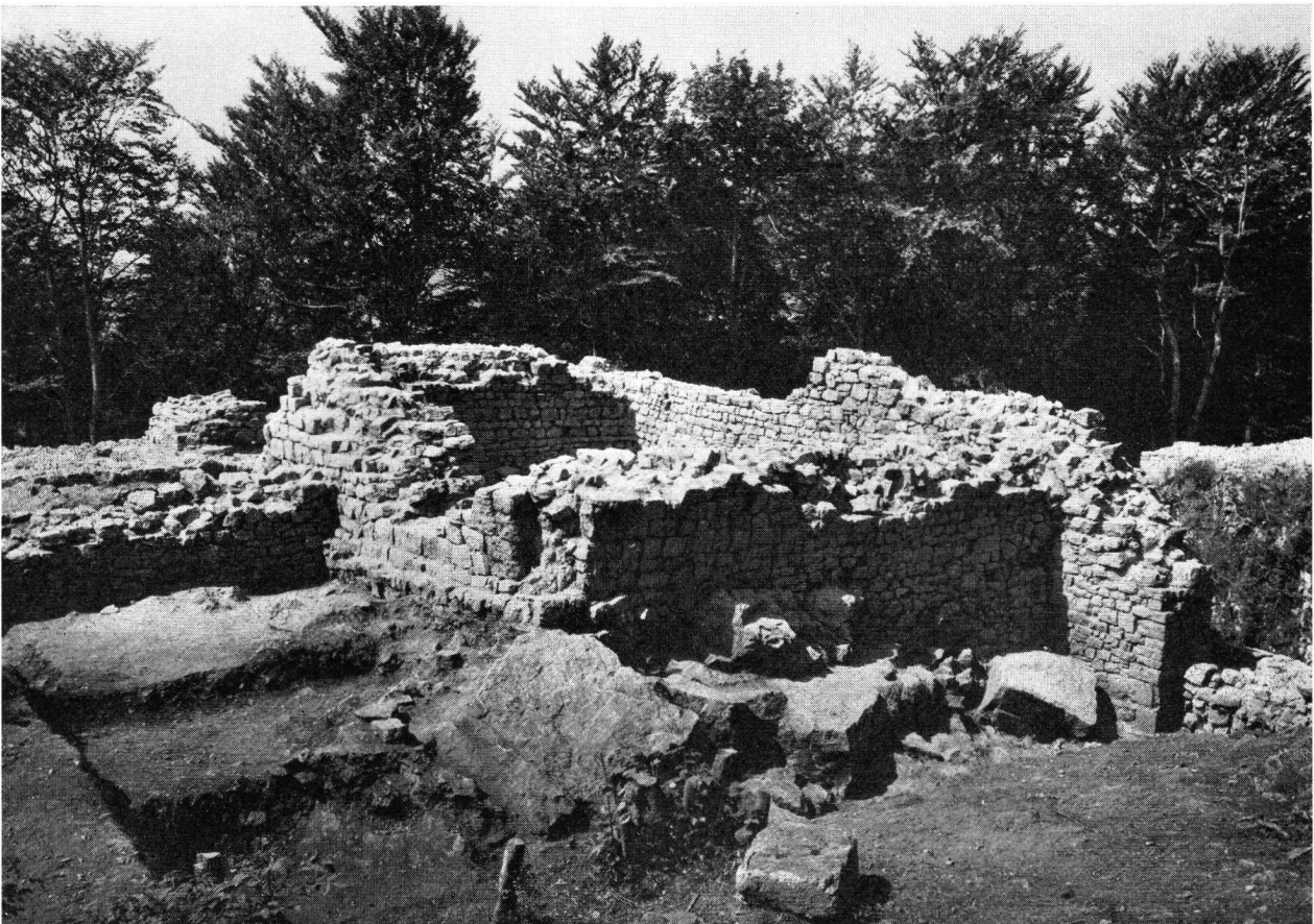
Frohburg, Zone F. Freigelegter Turm (M 38), Blick gegen Nordwesten.
