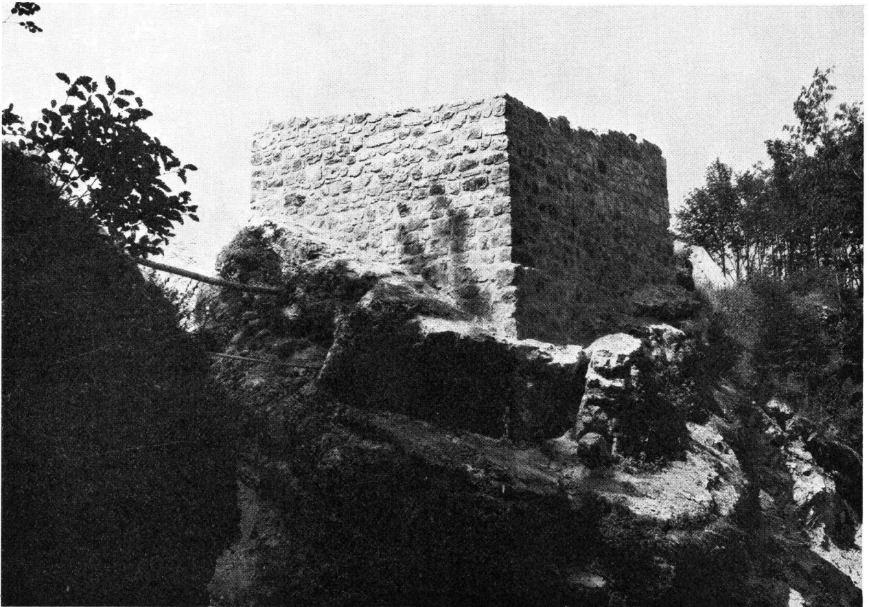
Frohburg, Zone T. Restaurierter Turm.
