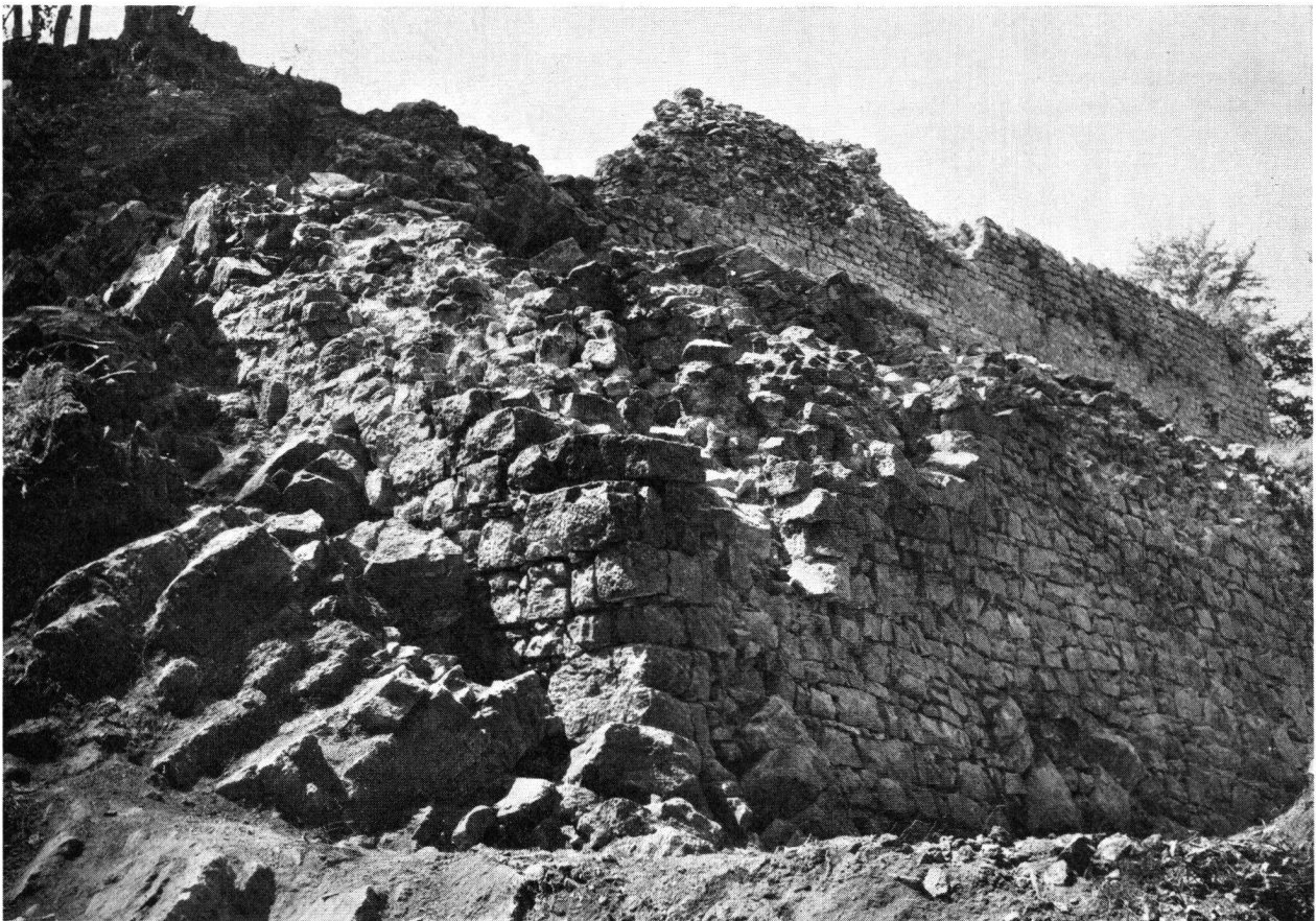
Frohburg, Zone G. Stützmauer im Halsgraben. Im Hintergrund Schildmauer der Hauptburg.
