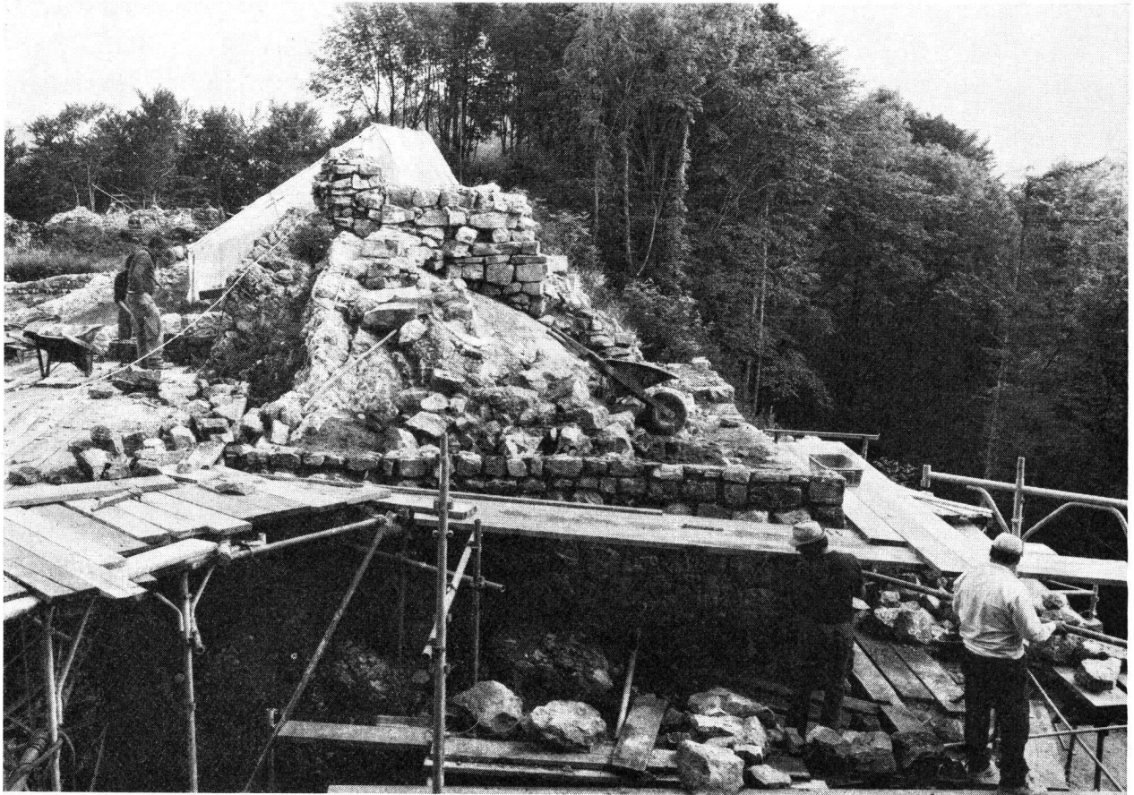
Frohburg, Zone T. Restaurierungsarbeiten am Turm.
