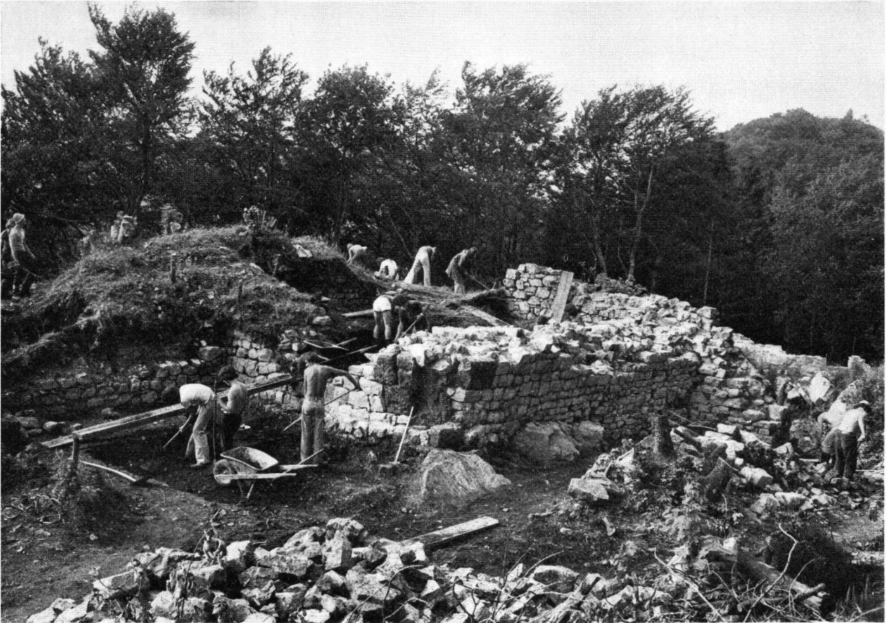
Frohburg, Zone F. Freilegung des Turmes (M 38).
