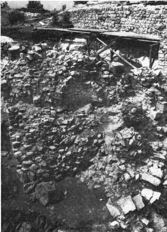
Frohburg 76. Fundamentreste des Rundturmes in der Nord- ostecke des Beringes
