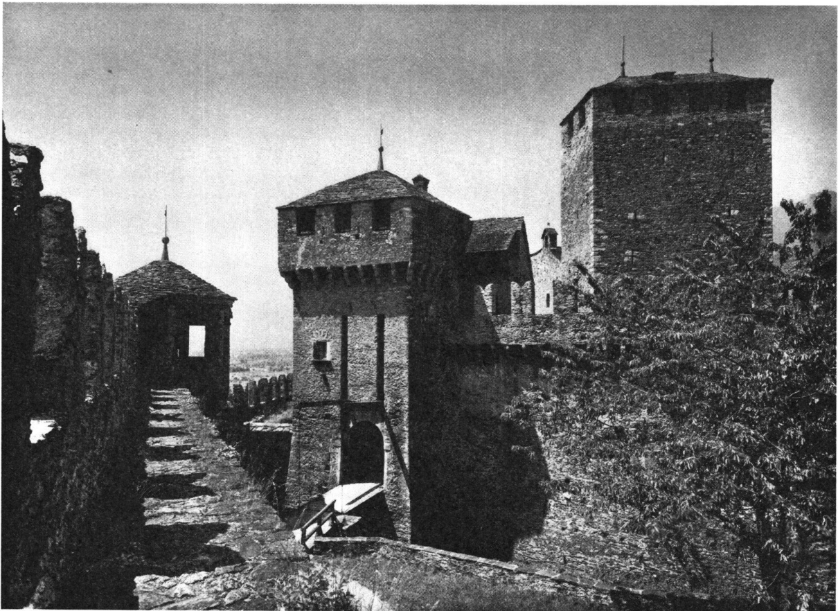
Bellinzona, Montebello. Wehrbauten mehrheitlich im 15. Jahrhundert errichtet.
