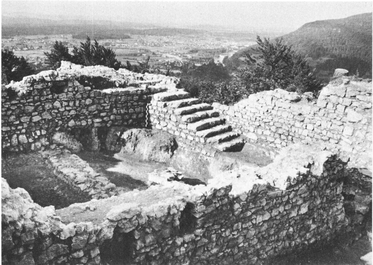
Alt-Wartburg AG. Inneres des Wohnturms. Nach vollständiger Freilegung für die Restaurierung vorbereitetes Mauerwerk
