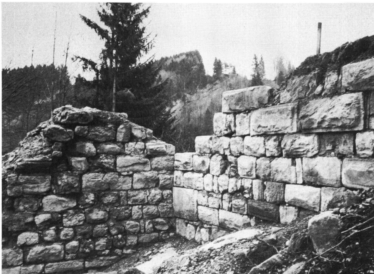
Urstein, aneinanderstossende Mauerzüge mit lagerhaft geschichteten Steinen. Foto Karl Diem, Herisau
