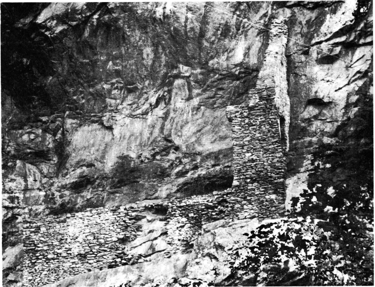
Malvaglia, casa dei pagani, Ansicht von Norden.
