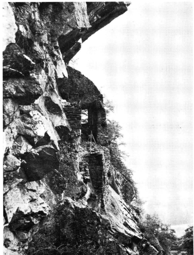
Malvaglia, casa dei pagani von Osten. Hinter der oben rund abgeschlossenen Hauptwand ist die Gebäudeplattform massiv aufgemauert.
