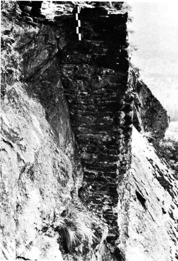
Malvaglia, casa dei pagani, östlicher Abschluss der Gebäudeplattform. Rechts des Massstabs das Loch des schräg laufenden Balkens, an welchem die hölzerne Erweiterung der Plattform ansetzte. An der Mauerkante ist die unsorgfältige Maurerarbeit deutlich zu erkennen.
