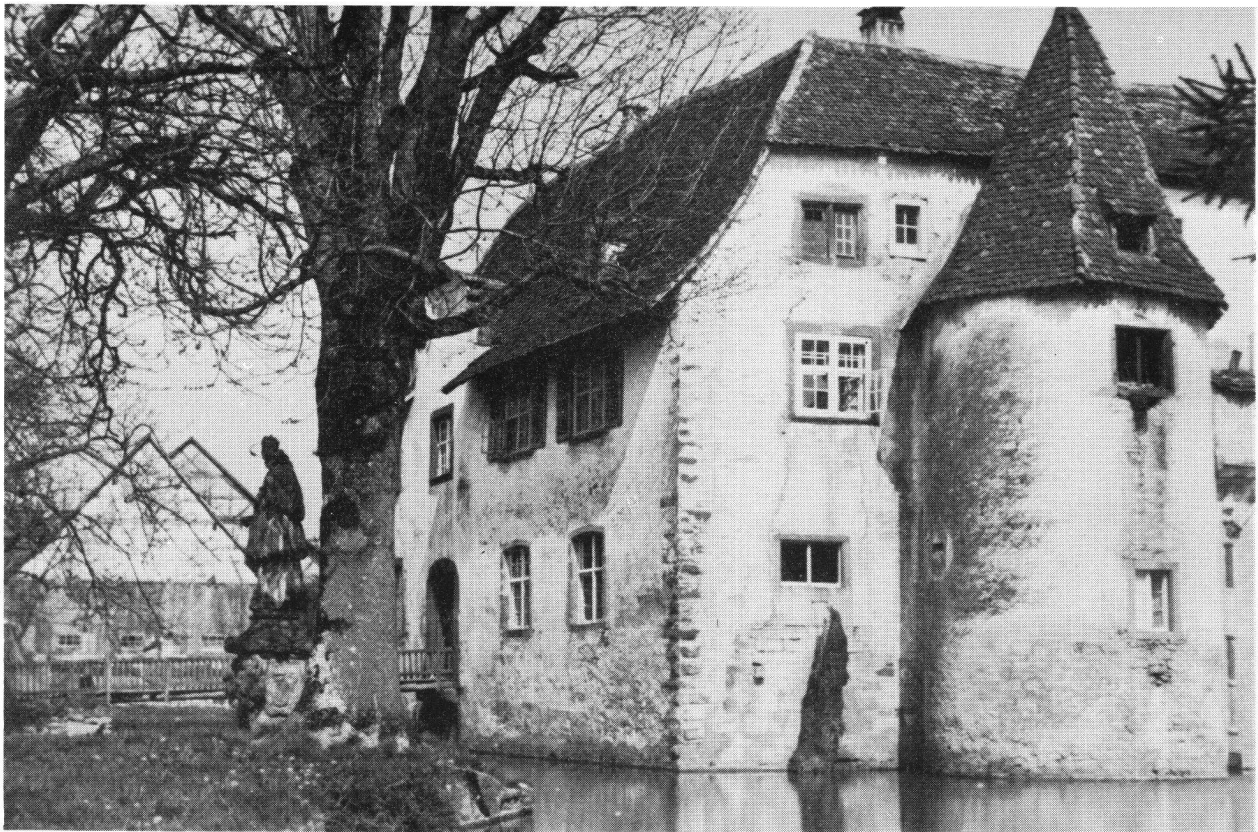
Wasserschloss Inzlingen, vor der Restaurierung.
