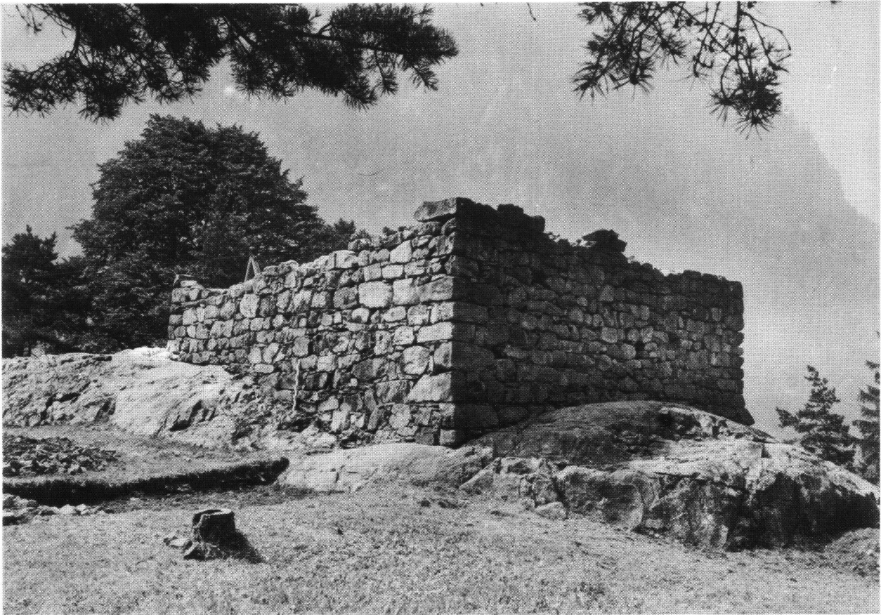
Zwing Uri UR. Turm vor der Konservierung nach der Reinigung der Krone und der Freilegung des Mauerfusses. Blick gegen NW.
