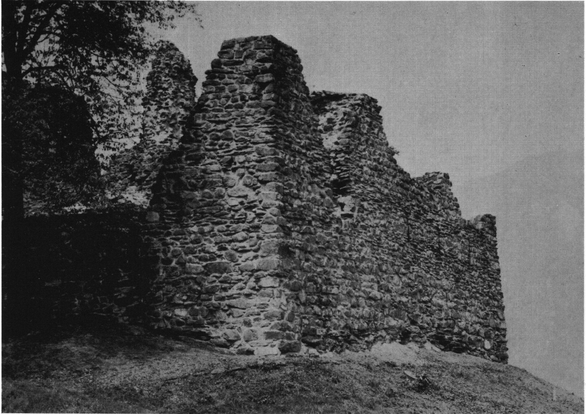
Attinghausen, Südtrakt, Ansicht von SW nach der Entfernung des Pflanzenwuchses.
