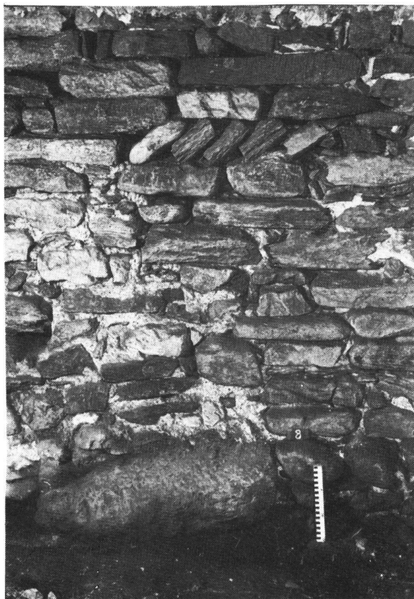
Salzhof in Brig VS. Fundamentbereich der Turmmauer M 1b (Aussenmantel).
