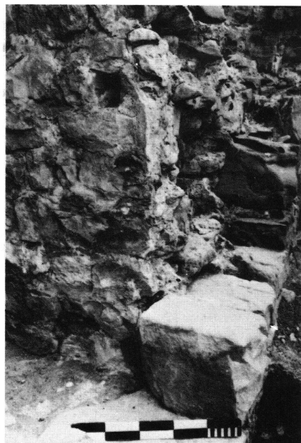
Seedorf, Eingang in den Burgturm mit Gewändstein und Kanal für den Sperr-Riegel
