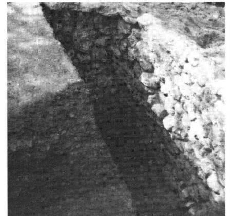
Fläche A, die südwestliche Ecke der Umfassungsmauer. In der südlichen Maueransicht sind die Risse deutlich erkennbar. Unter der westlichen Mauerpartie ist die ältere Mauer M 21 zu sehen.
