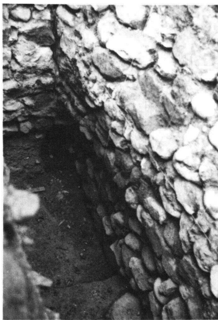
Fläche A. Unter der westlichen Umfassungsmauer liegt die ältere Mauer M21, die unter das Fundament der südlichen Umfassungsmauer läuft.
