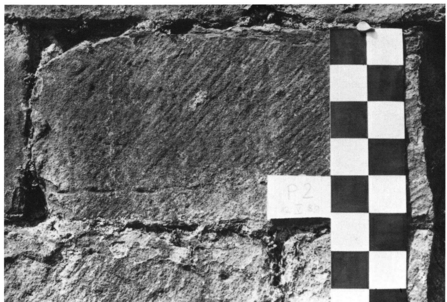
Foto 4: Sandsteinbearbeitung im westlichen Vorbau, unterhalb des mittleren Turmes
