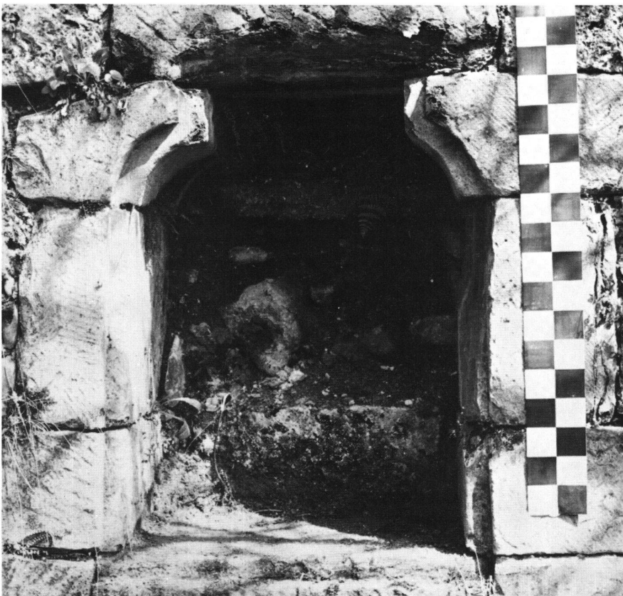
Foto 3: Kragsturzfenster im westlichen Vorbau, unterhalb des mittleren Turmes, 1. Viertel 13. Jh. (?)
