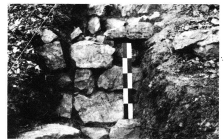
Riedflue, Umfassungsmauer M 2, Ansicht Aussenseite
