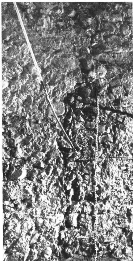
Kappel, «Einsiedlerhaus»: Eckverband. Gleiche Steinsetzungen und «Backenformen».
