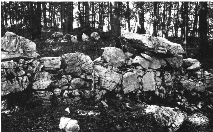
Burgli bei Glarus (Refugium). Reste der trocken geschichteten Umfassungsmauer.
