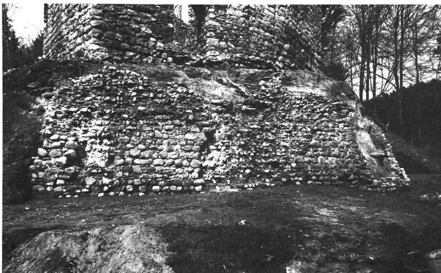
Abb. 5, Die Futtermauer M2 nach der Freilegung.
