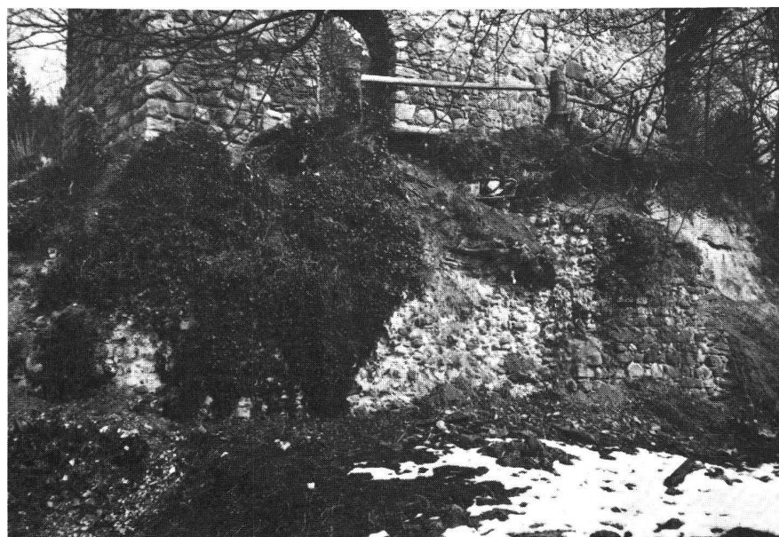
Abb. 3, Die Futtermauer M2 vor der Freilegung.
