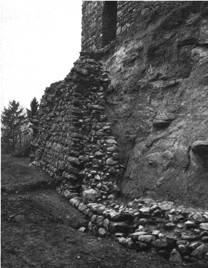
Abb. 7, Die freigelegte Mauer M2 von E. Gut erkennbar ist der Anzug der Mauer.
