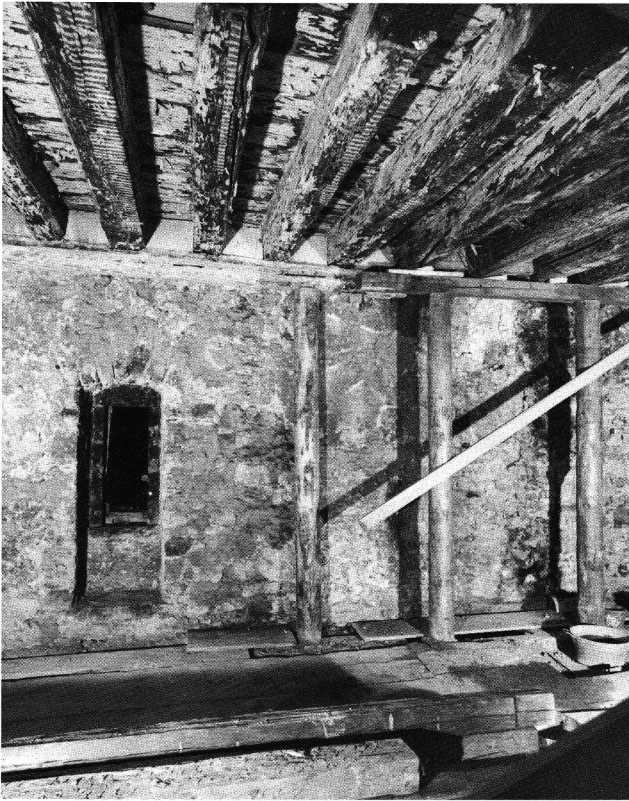
Abb.21: «Glentnerturm», Innenansicht an das Fenster im 3. Obergeschoss der Ostfassade. Unregelmässig dicht sind die mittelalterlichen Geschossbalken direkt ins Mauerwerk verlegt.
