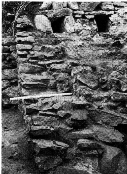
Abb. 7 Blick von Osten auf die südliche Begrenzungsmauer M7. Beim rechten Ende des Massstabes befindet sich die Fuge zwischen Mantel und Füllung.
