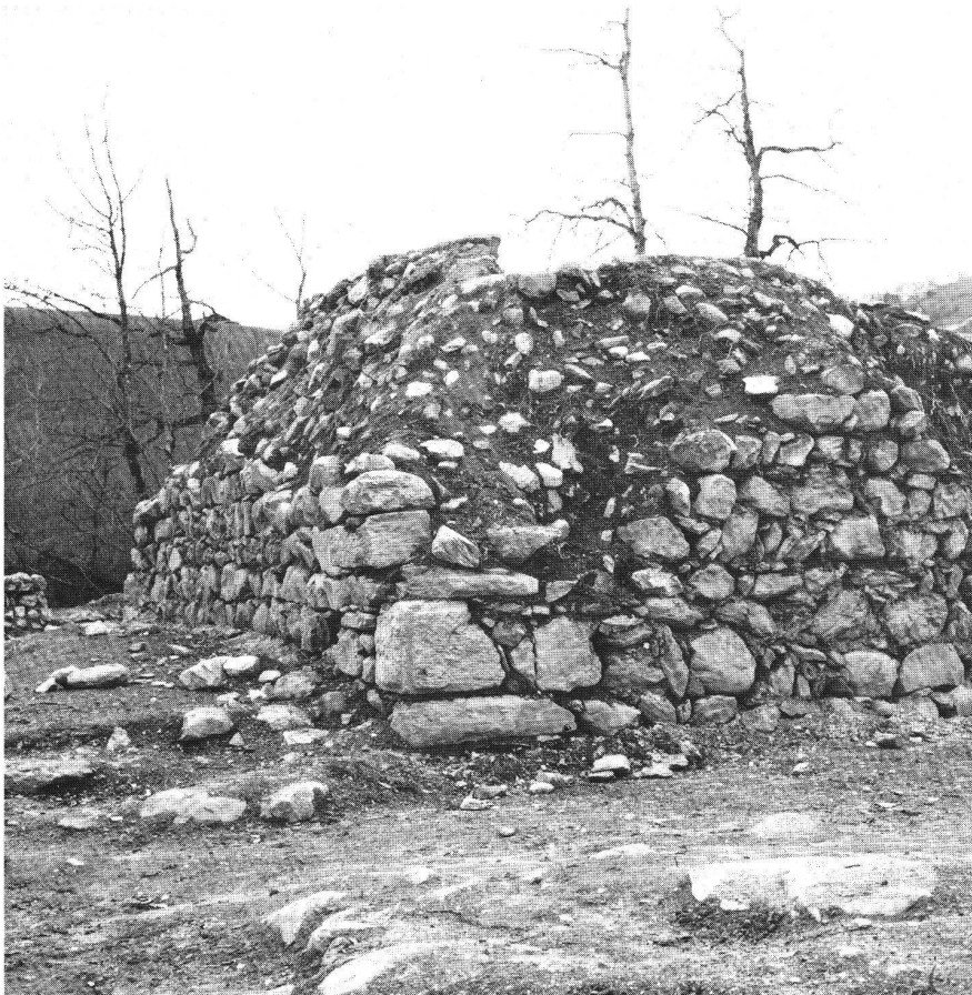
Burgstelle Grünfels bei Waltensburg (GR). Reste des Hauptturms unmittelbar nach der Freilegung. Das unkonservierte, sich selbst und der Vegetation überlassene Mauerwerk befindet sich nunmehr seit Jahren in Auflösung. Begonnen hatte die Tragödie seinerzeit mit unqualifizierten Freilegungsarbeiten durch eine Jugendgruppe unter der Leitung eines Pfarrers (!).
