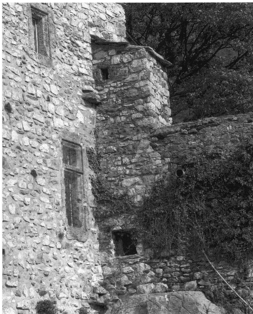
11 Latrine an der Westwand des Kalendenhauses (Gebäude C).
