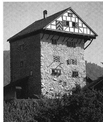
Neu-Altstätten. Wohnturm mit vorkragendem Fachwerkoberbau.
