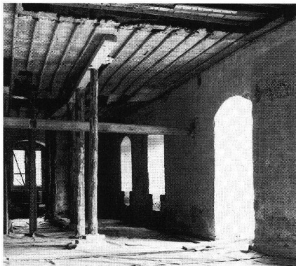
Palas von 1318. Unterer Saal mit den grossen Fenstern nach Norden und Westen. Die Deckenbalkenlage und Bretterdielen mit den gefästen Fugenleisten stammen aus der Bauzeit. Aufnahme nach Nordwest.
