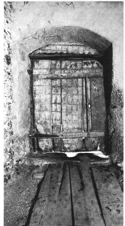
Palas von 1318. Unterer Saal: Portal in der Südwand mit originalem Türblatt. Es dreht sich oben noch mit einem herausgeschnitzten Drehzapfen im Drehloch des Sturzbalkens. Über Sturz und Türblatt zieht der Fehbesatz.
