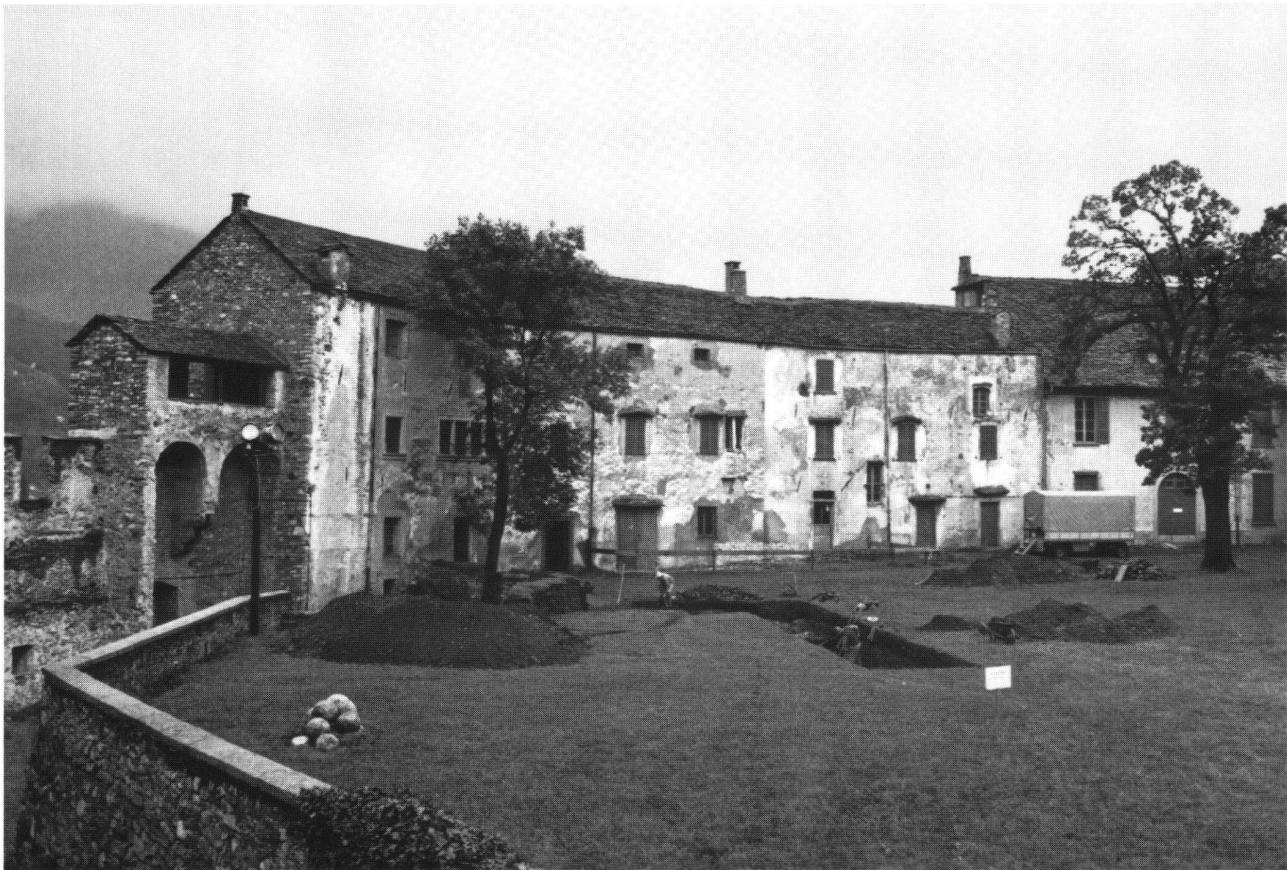
Castel Grande, Südtrakt, Zustand 1967.
