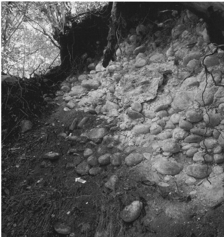
Abb. 10 Einer starken Verwitterung ausgesetzt sind die Mauerreste an der Westseite der Kernburg.
