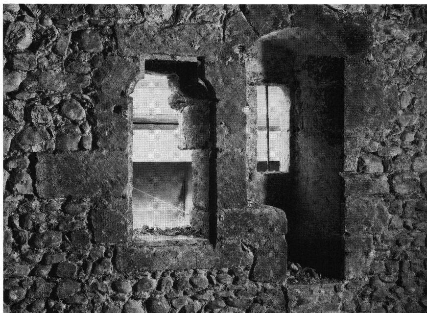
Fig. 8: Le couple baie à coussiège – niche-armoire conservé en façade nord. (C. Bornand, Lausanne)
