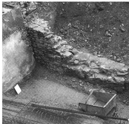
Abb. 11 Die Mauer M 2 ist älter als die jüngere, hier bereits verputzte Stadtmauer M 3 (links). Möglicherweise stammt sie von einem unvollendeten Turm.
