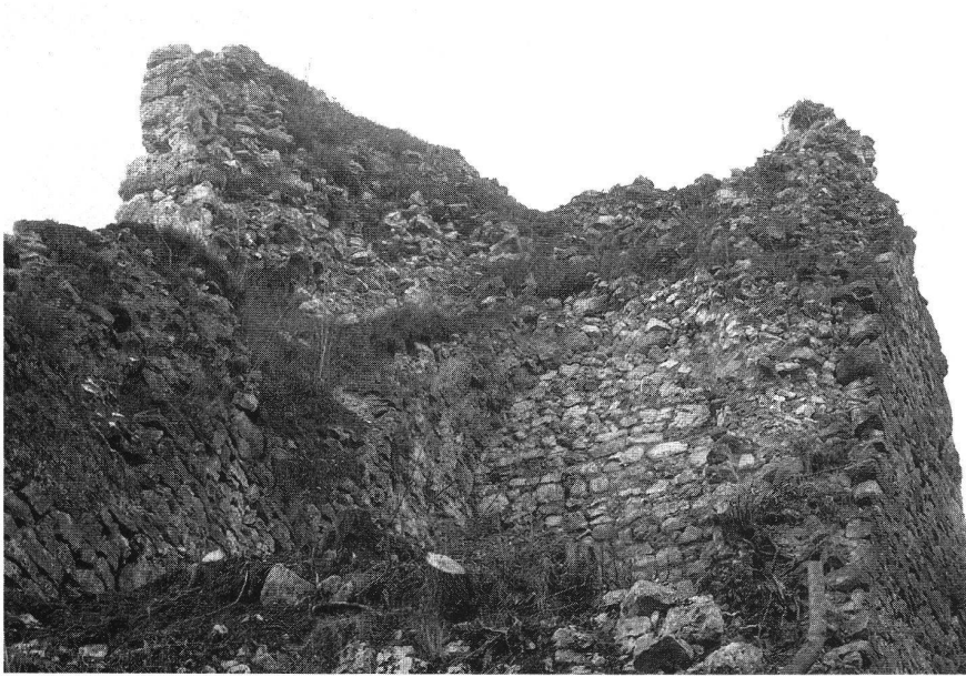
Château de Vorbourg, maçonnerie du château supérieur.
