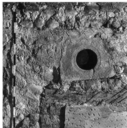
Abb. 5: Okulus aus der Kernbauzeit des «Rosskopfes»; möglicherweise lag er über einem zeitgleichen Türgericht, vgl. die Umzeichnung, Abb. 6.
