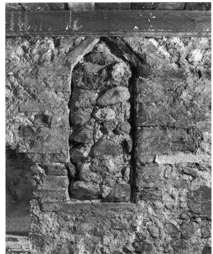
Abb. 8: Backsteinernes Fenster mit giebförmigem Sturz aus dem Erweiterungsbau des «Rosskopfes», spätes 13./frühes 14. Jahrhundert; vgl. die Umzeichnung, Abb. 9 (Pascale C. Rummler).
