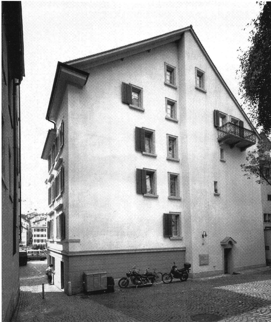
Abb. 15: Metzgergasse 3, «Tanzforst». Blick auf die heutige Ostfassade. Die ursprüngliche Fassade und spätere Brandmauer wurde durch die neuen Fensteröffnungen erneut zur Fassade.
