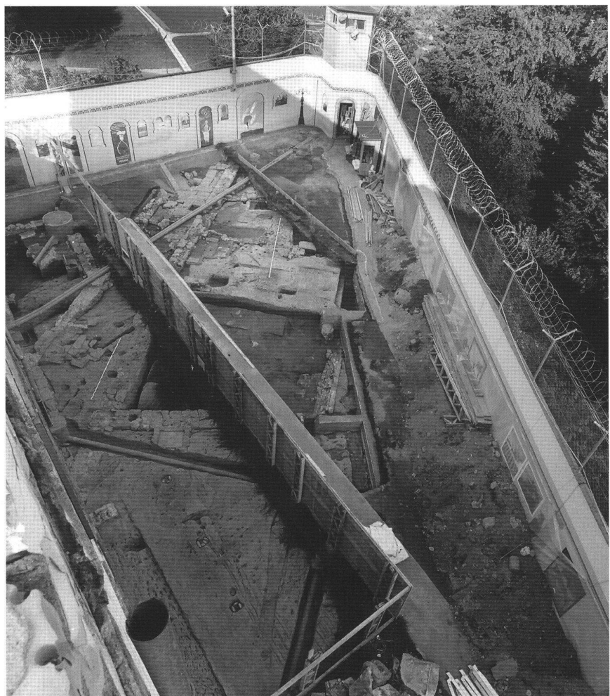
9: Westteil der Grabung, Blickrichtung Süd. Links sind die Grundmauern des Kreuzgangflügels zu erkennen; links davon die Reste der Zelle Nr. 3, rechts davon von vorne nach hinten die Zelle Nr. 6, der Garten 5 b, die Zellen Nr. 5 und Nr. 4.
