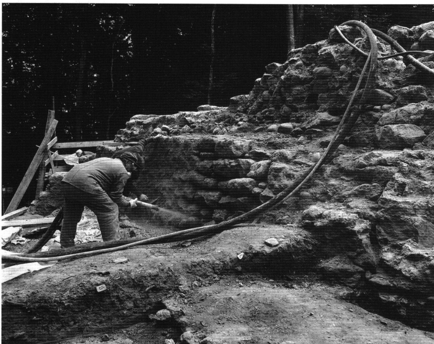
5: Der Ausschnitt Abbildung 10 während der Konservierung durch Kalkmörtelverfugung im Spritzverfahren.
