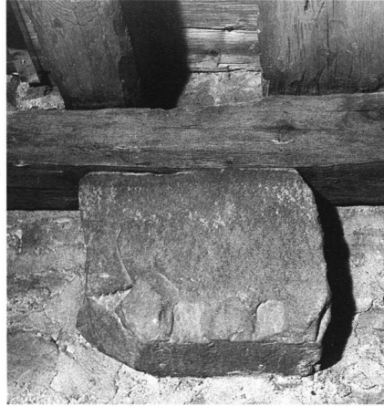
18: Wohnturm A von 1243, 2. Obergeschoss, Südwand: Konsolstein mit Streifbalken und Deckengebälk, am Stein sind unten Kerben für Spaltkeile sichtbar.
