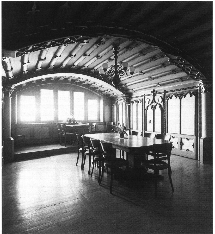
37: Palas D von 1451, Gotische Stube im 1. Obergeschoss mit gewölbter Bohlenbalkendecke von 1451; Wandtäfelungen und Erker (mit erhöhtem Boden) von 1850.
