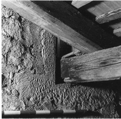
24: Wohnturm A von 1243, Ostfassade: Fensterchen zum 3. Obergeschoss und originaler Fassadenputz von 1243; seit 1850 als Dachstuhl-Auflager.
