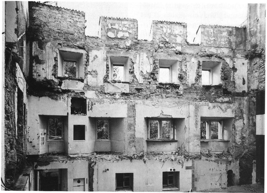
40: Nordansicht an die mittelalterliche Schildmauer, später mehrfach erhöht und 1972 durch Fenstereinbauten stark durchbrochen; rechts der ummauerte Palas von 1451 mit Türausgang zu einem zeitweiligen Wehrgang.
