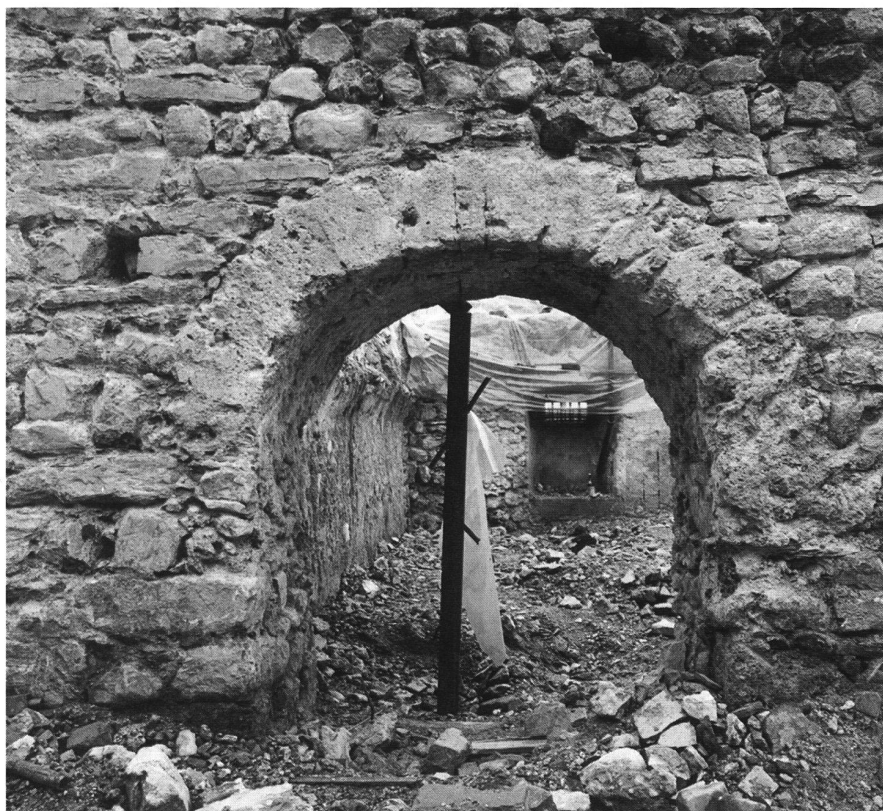
12: La porte d'accès au rez-de-chaussée de la tour.
