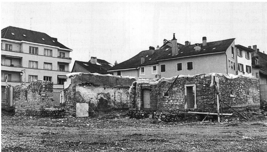
3: La tour et la maison du métral après démolition des bâtiments du XIX e siècle.
