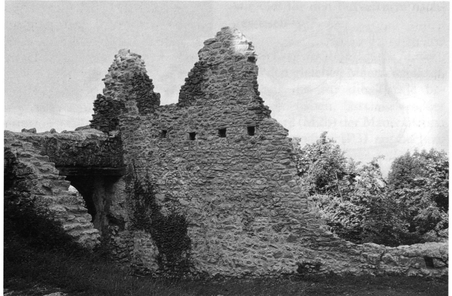
15: Westlicher Innenwinkel des Torhauses von Nordosten im Zustand 1999 nach der Konservierung.
