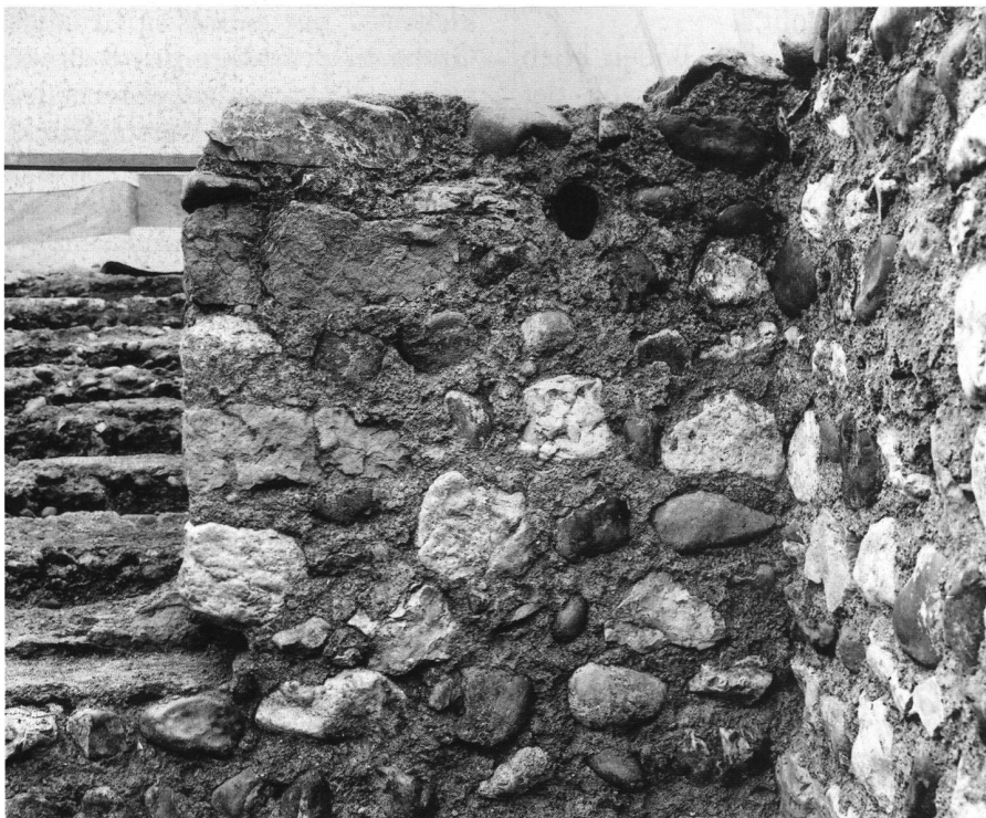
15: Teilansicht der nordöstlichen Kellerecke mit eingemauertem Topf.
