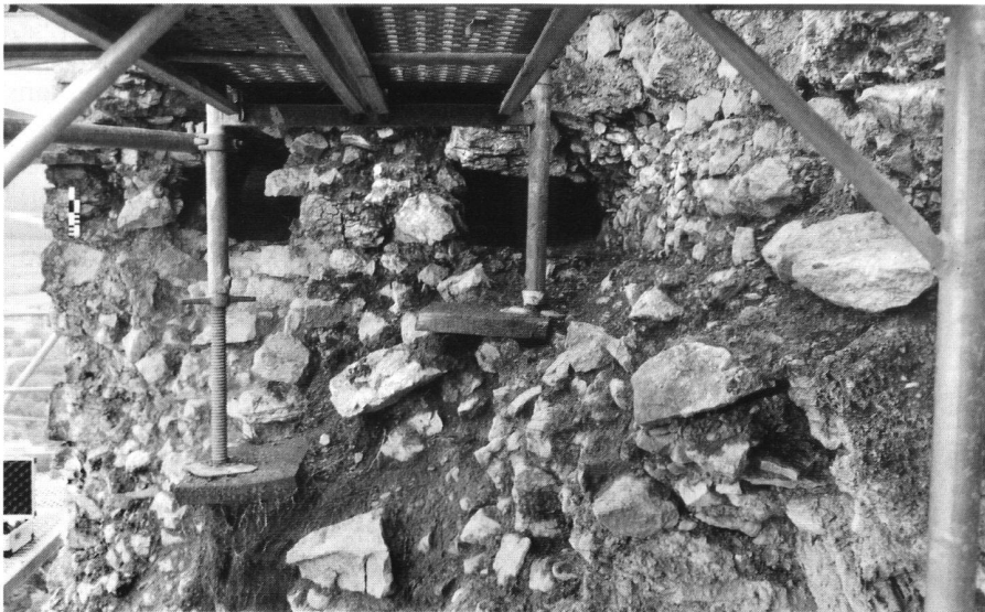
14: Mur M7. Trous des ancrages 22 et 23; vue du N.
