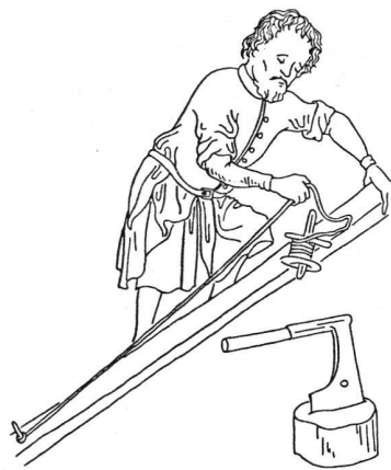
5: Zimmermann beim Einrichten eines Werkstückes mit der eingeschwärzten Schnur 5 .
