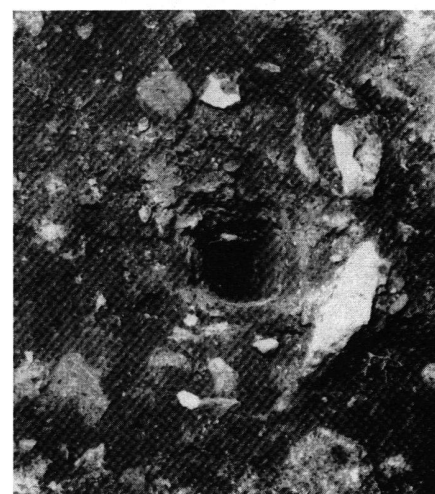
19: Bettingen BS – Chrischonakirche. Abdruck des Messpflockes unter dem Altar. Ringsum die Keilsteine.
