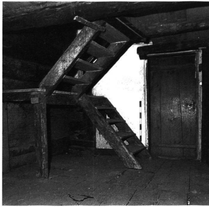
9: Haus Nr. 5/6, 2. Obergeschoss: noch bis zu den neuesten Umbauten stand der einst als Küche bis zum First offene Hausmittelteil partiell offen und diente lediglich der Hauserschliessung und als land- und hauswirtschaftlicher Abstellraum.
