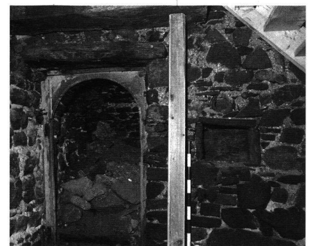
8: Haus Nr. 5/6: Kellertrennwand von um 1265 mit Rundbogentür, Wandnische und darüber einem eingemauerten Kochtopf; links die Stadtmauer.
