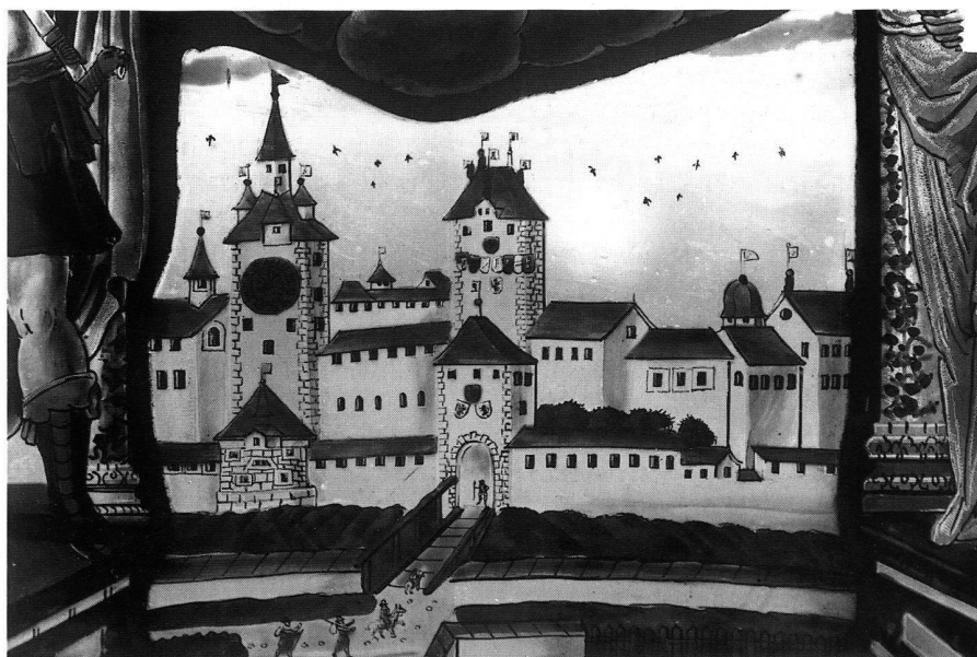
1: Ansicht von Bremgarten von Osten. Links der Spittel-, in der Mitte der Platzurm. Glasgemälde 1677.
