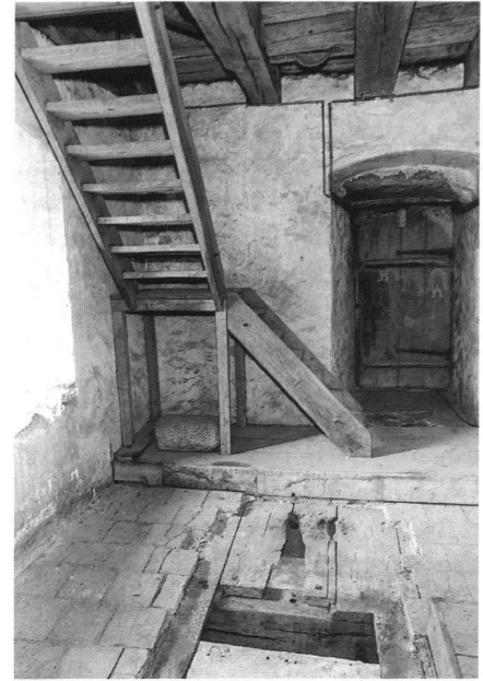
8: Spittelturm, 2. OG mit Loch zum Gefängnis und Seilrolle an der Decke (von Süden, Podest und Treppenverlauf nicht ursprünglich).
