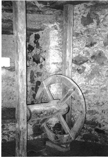
7: Hexenturm Bremgarten. Die Aufzugsvorrichtung über der Kerkeröffnung.
