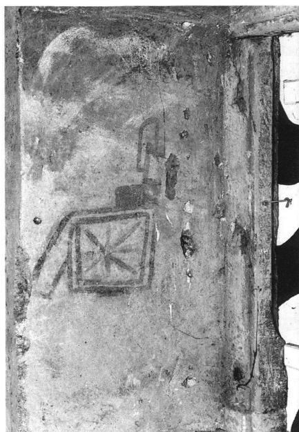
33: 3. OG Treppenhaus: Darstellung einer Guillotine im westlichen Fenster (Koble, Ziegelkeride. Höhe 50 cm).
