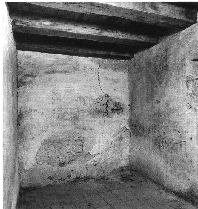
6: Südwestecke des Gefängnisraums.
