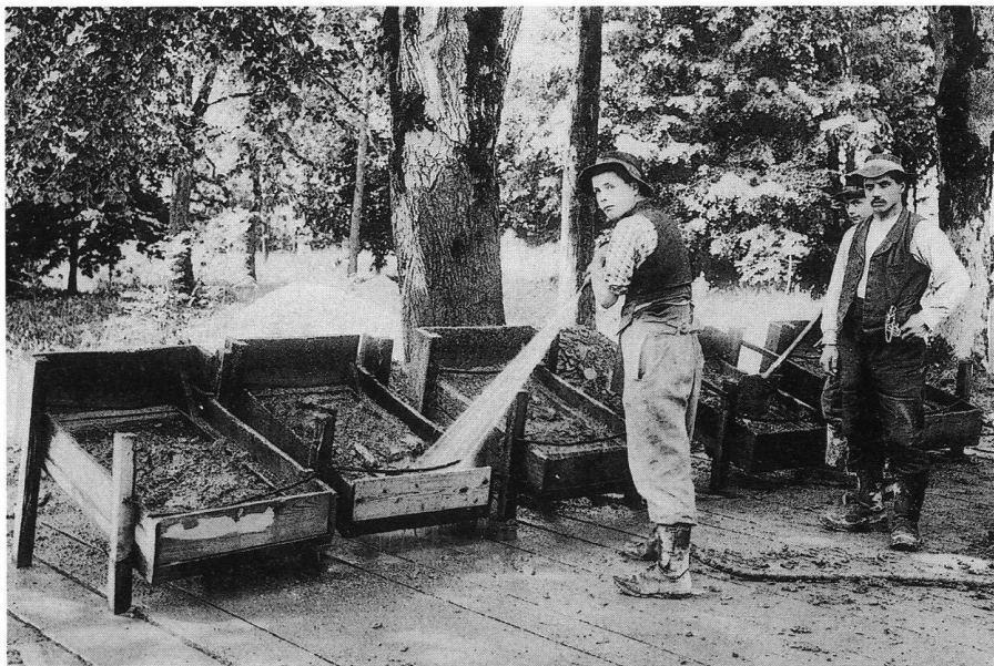
10: Eine der drei Schlämmanlagen. Foto Wolfsgruber, 1911.
