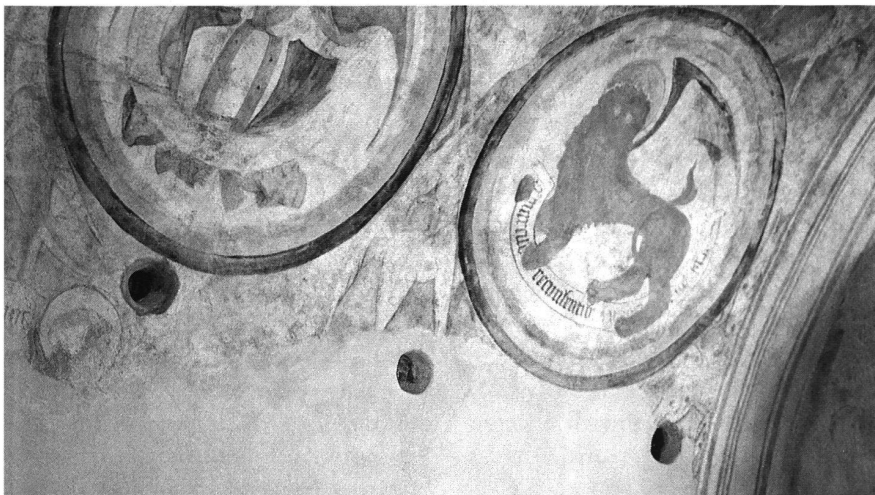
7: Les trois vases de la paroi nord du temple de Villette. – Ansicht von drei Schalltopföffnungen in der nördlichen Seitenwand der Kirche von Villette.
