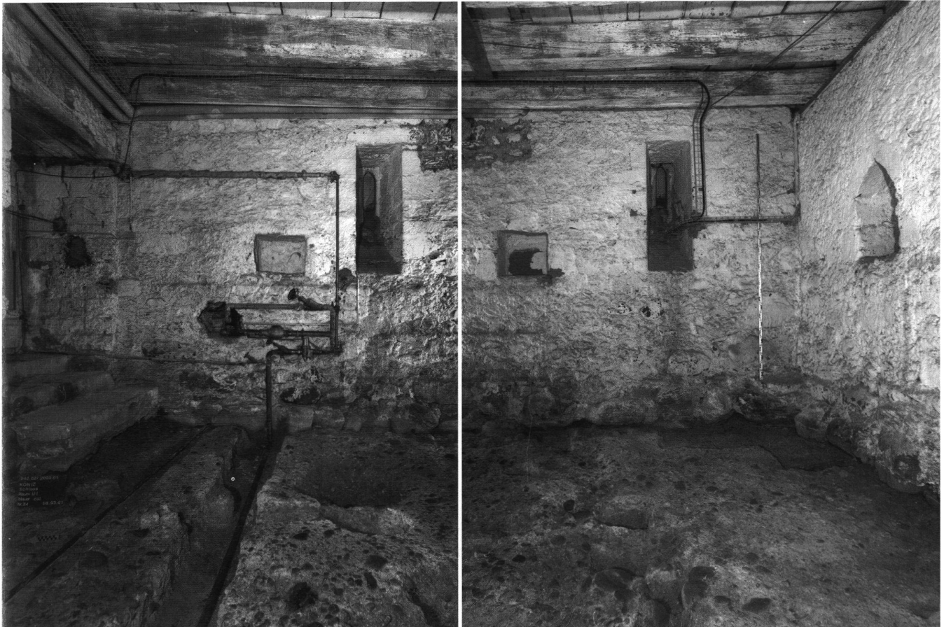
10: Der Keller des Saalgeschosshauses. Blick nach Osten mit Eingangstür, Lichternischen und schlitzartigen Spitzbogenfenstern.
