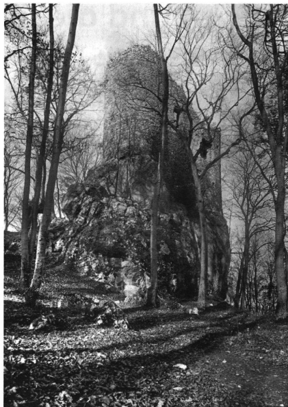
2: Ruine Reichenstein (Arlesheim, BL), Zustand vor dem Wiederaufbau.
