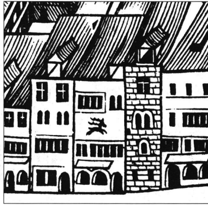
3: Murervedute: «Hirschli» (Niederdorfstrasse 3). Unter dem sprechenden Hauszeichen bringen ein fünfteiliger Fensterwagen und ein Pfostenfenster Licht in die beiden gassenseitigen Räume des 1. Obergeschosses.
