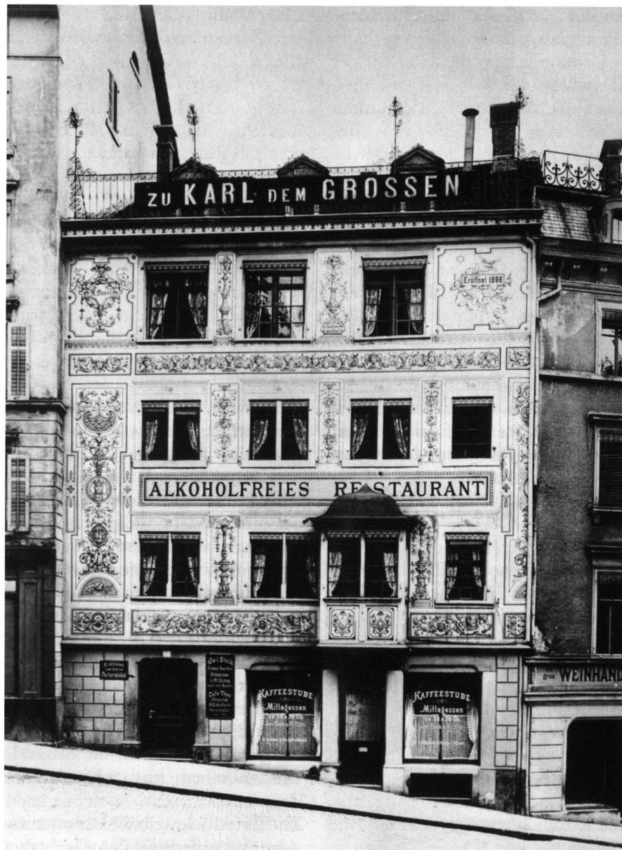
28: «Goldener Stern» (Kirchgasse 14). 1897 wurde die Fassade des zur Wirtschaft umgebauten Hauses mit Sgraffitotechnik geschmückt.
