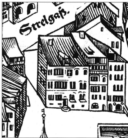
21: Murervedute: «Grünberg» (St. Peterhofstatt 10). Der eingemittelte Zugang wurde einst über eine repräsentative Portaltreppe erreicht. Eines der ganz wenigen Beispiele solcher Treppenerschliessung in der Zürcher Altstadt.
