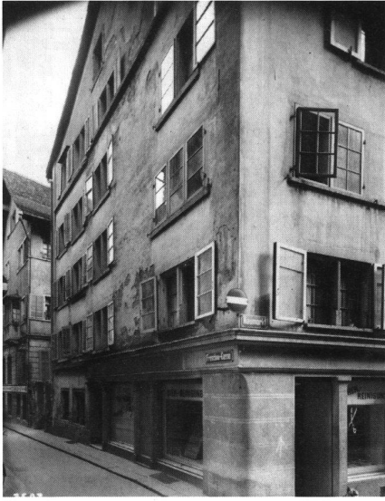
18: «Neuburg» (Froschaugasse 2). Die Profilmälze der spätgotischen Rechteckfenster dienen als Auflager für die im 20. Jahrhundert aufkommenden Vorfenster, meist aber für die älteren Fensterläden.
