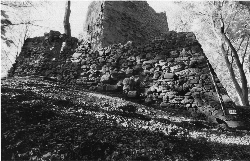
31: Südbastion vor der Restaurierung.
