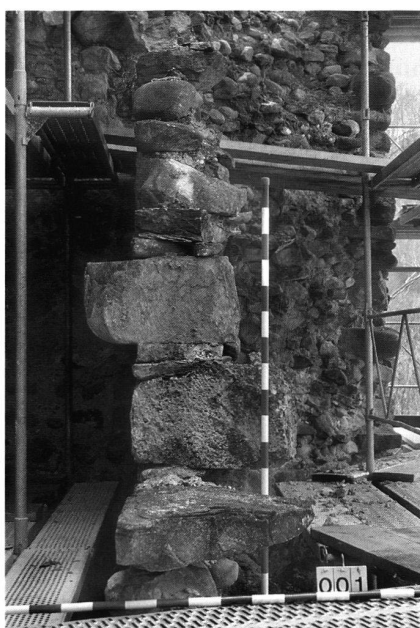
23: Südliches, inneres Türgewände des Hocheingangs.
